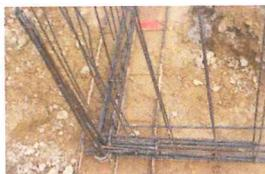
Nœud de chaînage - Continuité mécanique
