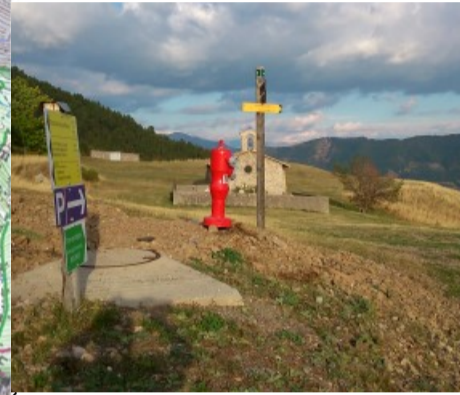
Mise en service le 26 septembre 2016 de la borne incendie n° 8
