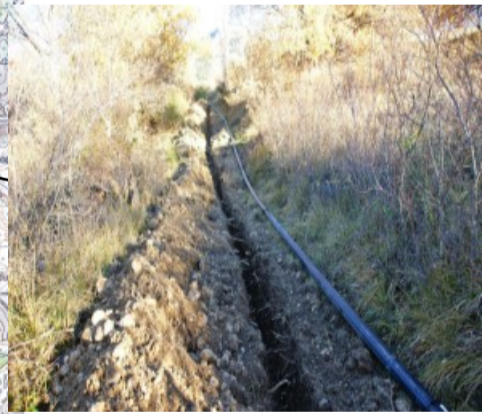
Remplacement de 60m de canalisation 110 mm,
