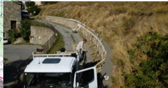
Consolidation haut de muret à Mélan
