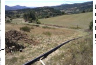
Remplacement de 400 ml de canalisations principale 2010
