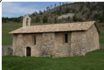
Remplacement toiture église de Mélan en 2010
