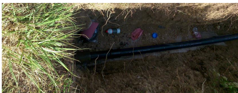
Raccordement à la traversée gainée en 2010 du vallon des Collons
